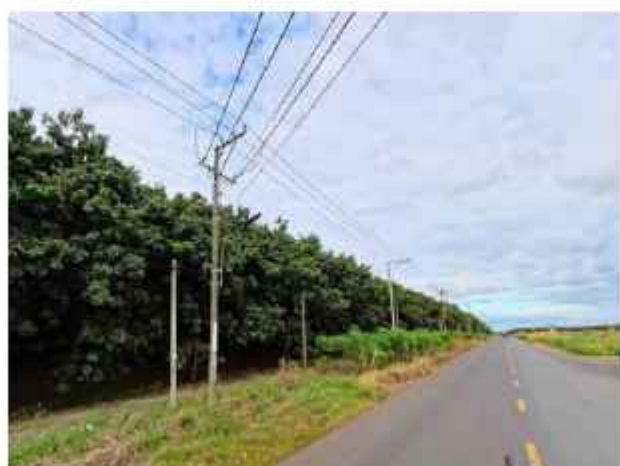
c) Tuyến đường DH507 (Khu B)
